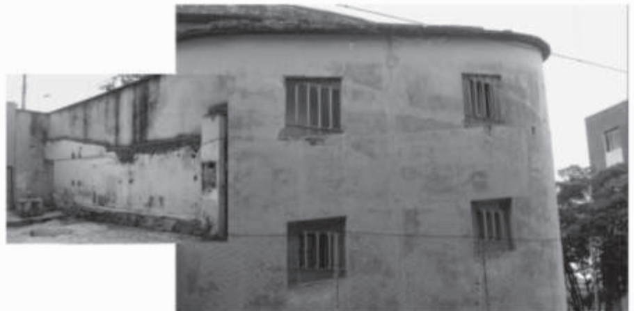
Partes externas da CEAL em reforma.
